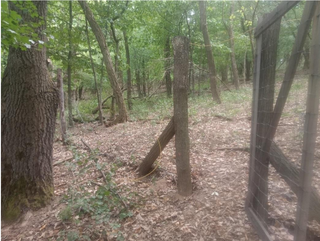
Szarvasok által megrongált-szétszakított kerítés
