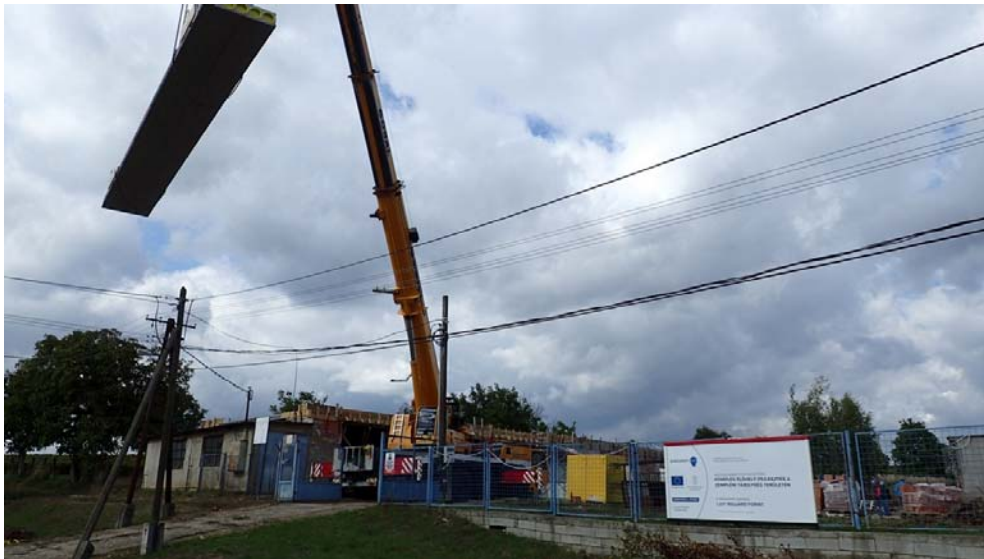
A leendő gazdálkodási központ építési munkái
