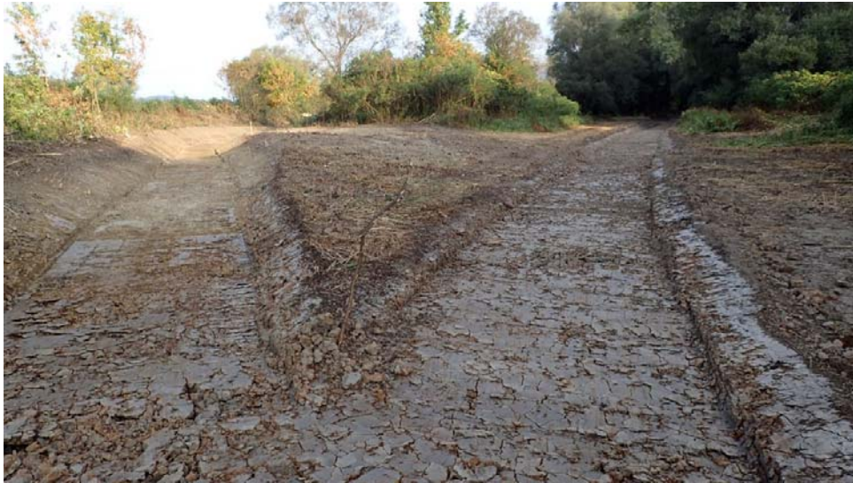
Tápláló csatorna kialakítása
